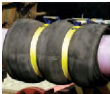
25-сурет. Құбырдың түйіскен жеріндегі резеңке құрсау
